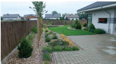
Oczyszczalnia SBR Primo+ wkomponowana w kruszywo
